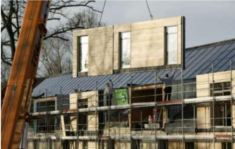
beidseitig geschlossen, Fertigung im Werk
